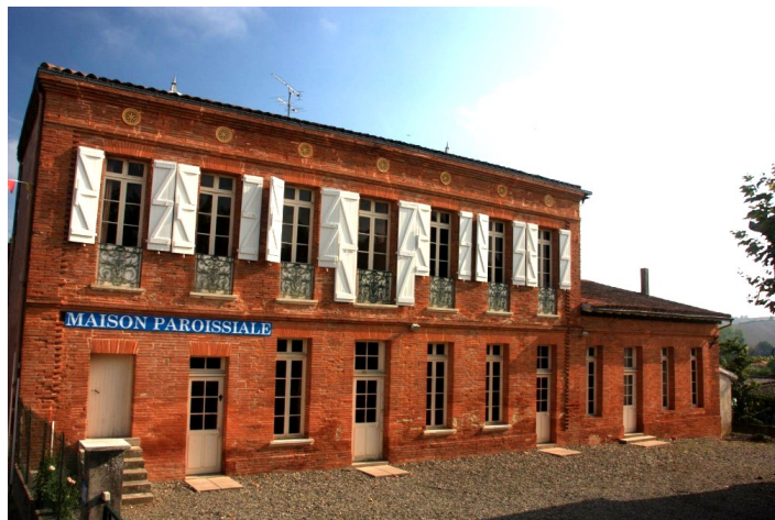
Façade sud de la Maison Paroissiale
