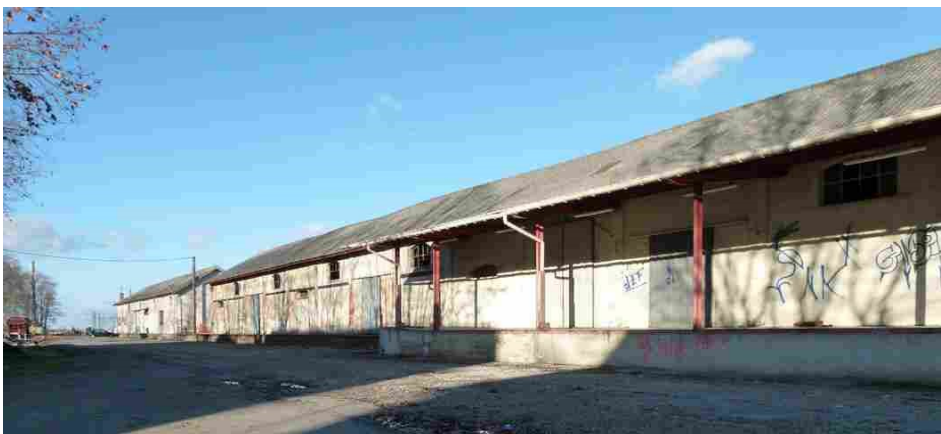
Bâtiments et entrepôts avant leur démolition pour travaux de modernisation de la gare
